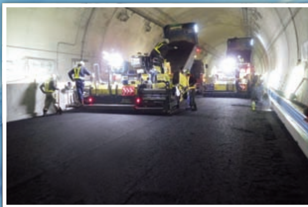
(357号東京港トンネル・東京都)
