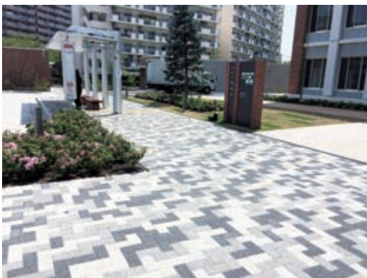
大学キャンパス内の施工事例
