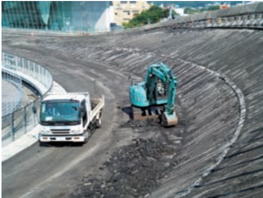
既設舗装撤去状況
