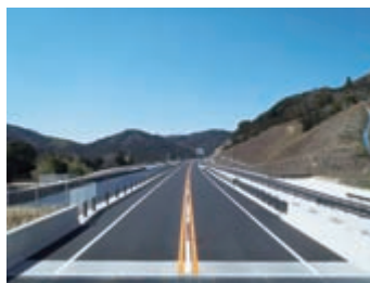
平成25年度 23号蒲郡BP柏原地区舗装工事
