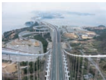
平成24年度 坂出管内橋面防水他工事
