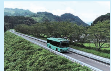
BRT専用道の一部に「PETアスコン」を施工した「日田彦山線BRTひこぼしライン」(2023年)
