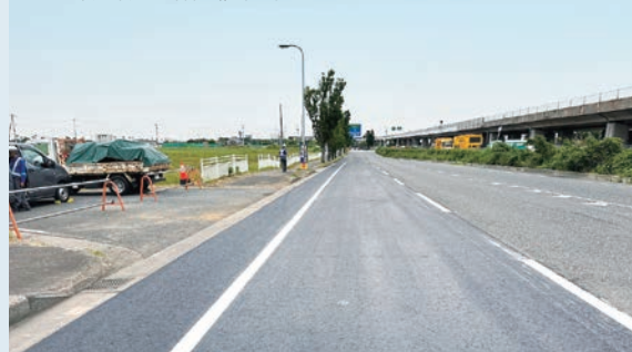
「バイオ炭アスコン」を施工した R6-R8木更津出張所管内維持工事
