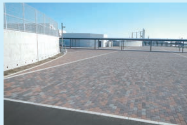
「レインボーエコロブロックBiz」を施工した八戸市多賀多目的運動場の広場(2016年)
