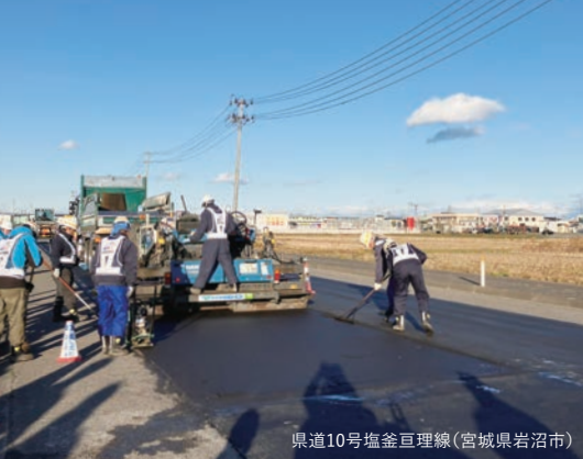
県道10号塩釜巨理線(宮城県岩沼市)
