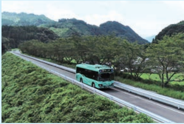
BRT専用道の一部に「PETアスコン」を施工した「日田彦山線BRTひこばしライン」(2023年)
