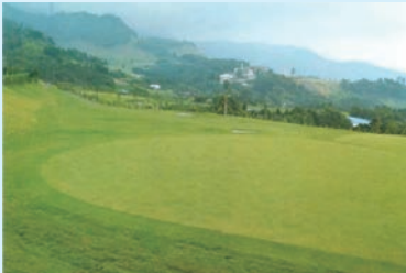
大秦野カントリークラブ造成工事(1977年)
