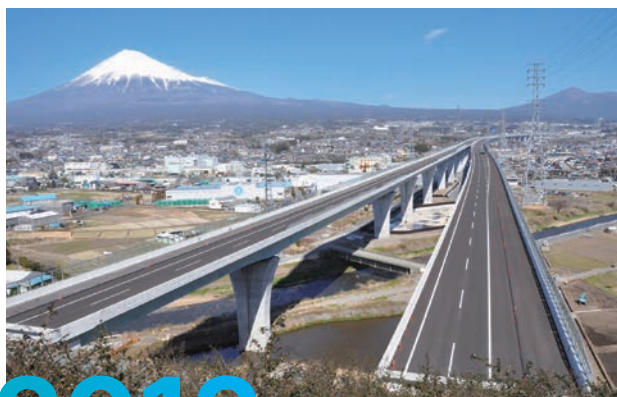
新東名高速道路 富士東舗装工事
