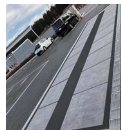
太陽光発電舗装
