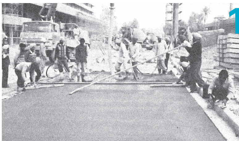
マレーシアでの施工風景
