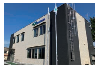
2023年の建て替え時に「Nearly ZEB」認証を取得した北総営業所
