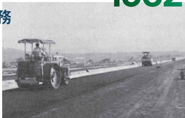
名神高速道路 吹田・茨木舗装工事
