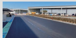
「バイオ炭アスコン」施工事例 (土浦テクノBASE内)
