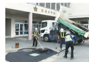
小学校構内の部分舗装復旧による水たまり解消
