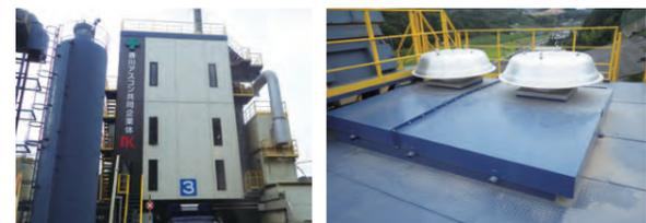
騒音・粉塵対策バッチタワーによる囲い 大型換気扇採用粉塵高温対策
