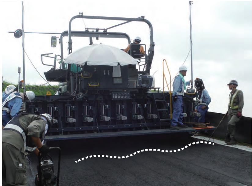
コンピュータ制御されたスクリードによりアスファルト合材を様々な横断形状に敷き均しすることが可能
