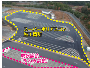
新東名高速道路 浜松S.A.（上り）
