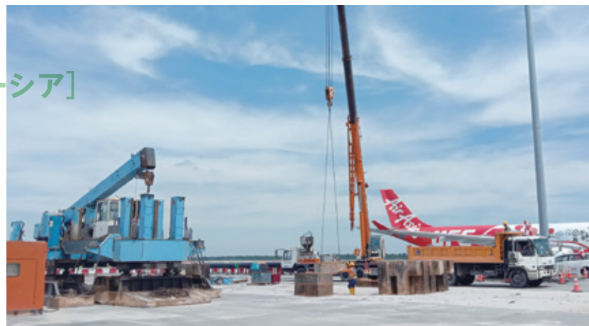
工 事 名：ペトロナス燃料管補修工事(Q16ベイ) 施 主：KUALA LUMPUR AVIATION FUELLING SYSTEM SDN BHD(KAFS-ペトロナス社の子会社) 工事 場所：マレーシア国セランゴール州セパン 工 期：2019年12月～2020年10月 工事 概要：ジェット燃料の給油管(延長162m)の入替工事、既設管を撤去後、新たに杭基礎とRC版および60cm径の給油管を敷設
