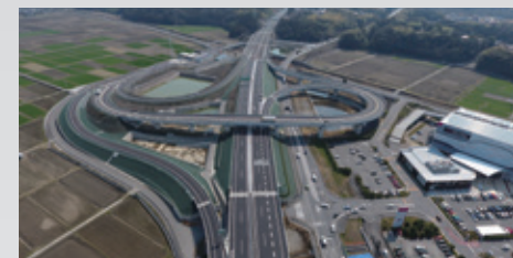
東海環状自動車道 大安IC～東員IC間舗装工事
