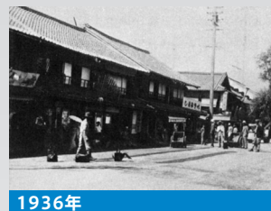
1936年 松山市内道路舗装工事
