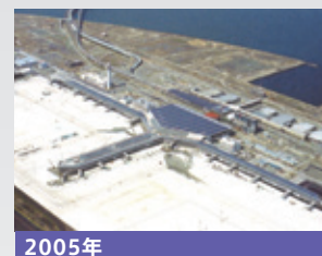
2005年 中部国際空港(セントレア) エプロン舗装工事
