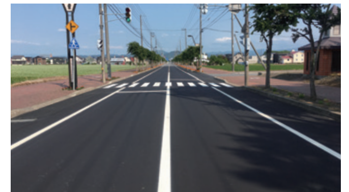
工 事 名：学園新十津川(停)線外舗装工事(道債) 発 注 者：北海道空知総合振興局 札幌建設管理部 工 期：2019年2月15日～2019年7月10日 工事 場所：北海道樺戸郡新十津川町
