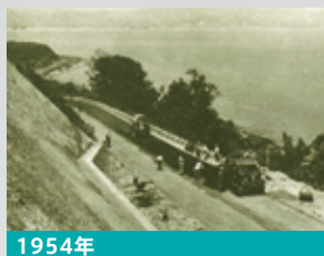
1954年 札幌国道舗装工事
