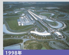
1998年 セパン・インター・ナショナル・ サーキット新設工事(マレーシア)
