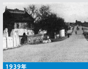
1939年 広安門～盧溝橋舗装工事 (中国:北京市)
