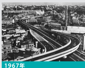
1967年 首都高速2号線舗装工事
