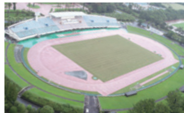
ひなた宮崎県総合運動公園内の陸上競技場（宮崎県宮崎市）
