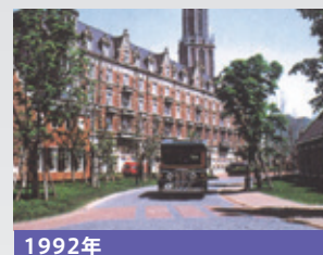
1992年 長崎ハウステンボス園内 舗装工事
