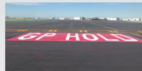
東京国際空港B滑走路取付誘導路舗装工事
