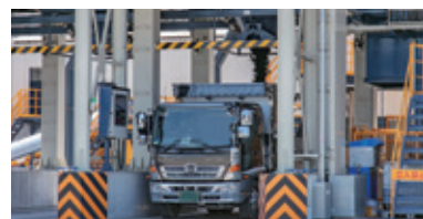
車両番号と合材の種類を案内し、積み込み状況を確認できる「トラックアシストシステム」
