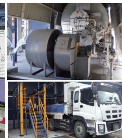
安定的なNOx（窒素酸化物）の大幅低減を実現した高性能省エネガスバーナー。A重油に比べてCO 2 排出量の削減にも貢献します
