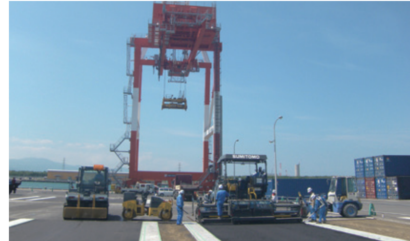
工 事 名：花畔ふ頭用地舗装工事その2 発 注 者：石狩湾新港管理組合 工 期：2017年4月～2017年9月 工事 場所：北海道石狩市
