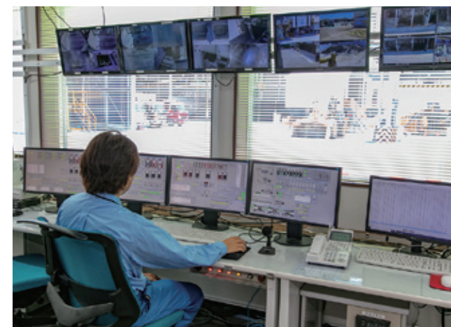
スムーズな誘導で安全かつ確実な合材の出荷と積み込みを可能にする最新設備を備えた操作室
