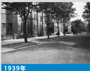
1939年 東京帝国大学構内舗装工事
