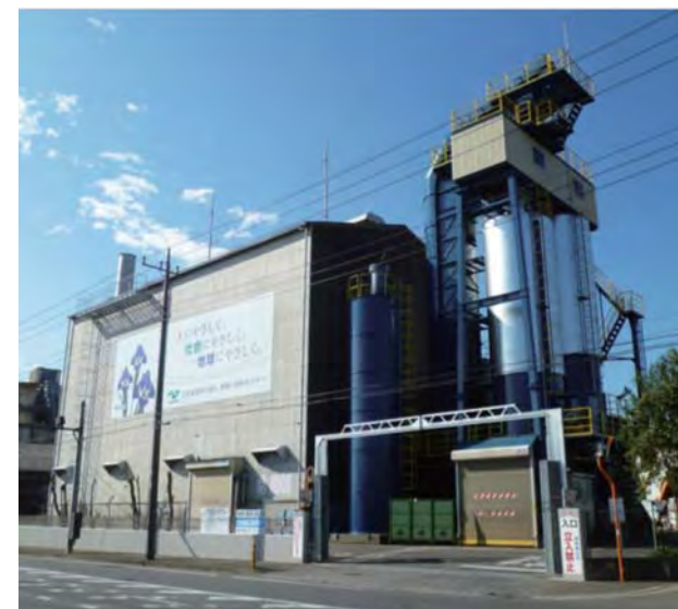
神奈川合材センター全景
