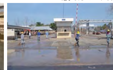
構内清掃状況
