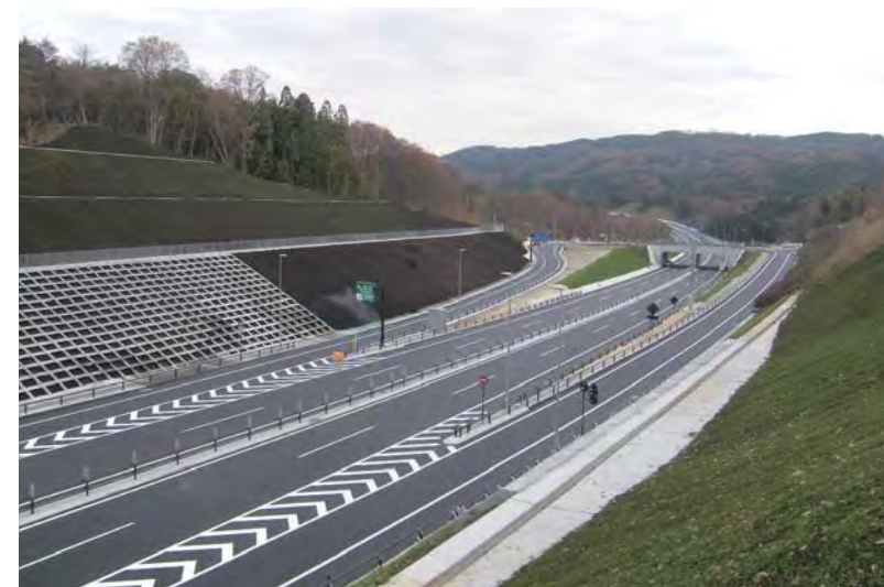
工事完成写真
