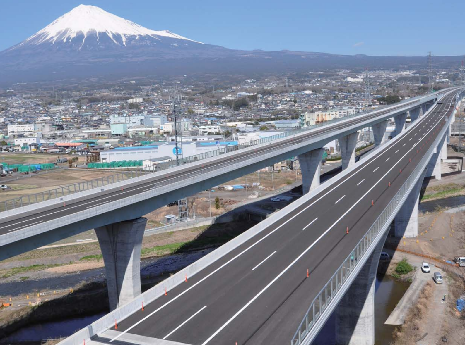
新東名高速道路 富士東舗装工事
