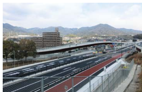
西広島バイパス廿日市舗装第1工事（広島県）
