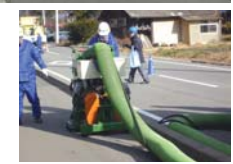
福島県除染試験施工
