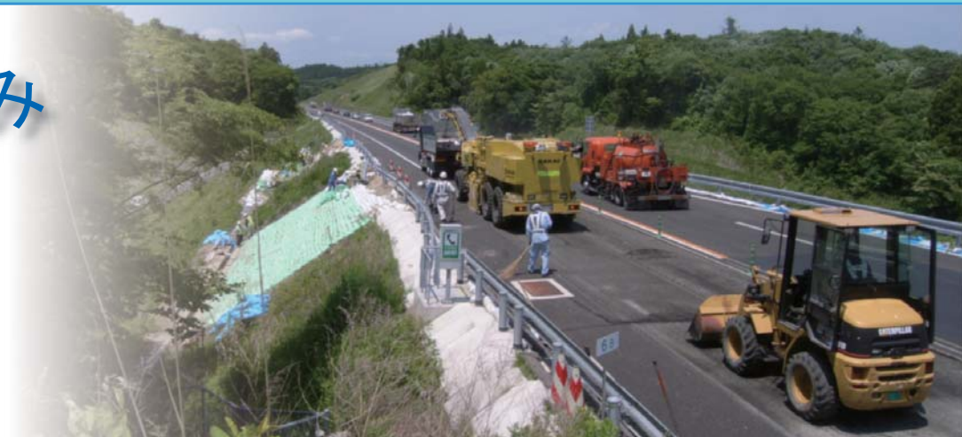
(一関～利府しらかし緊急舗装復旧工事)
