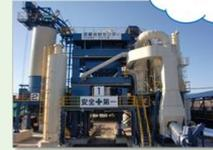
バーナー燃料として廃食油を使用しアスファルト合材を製造
