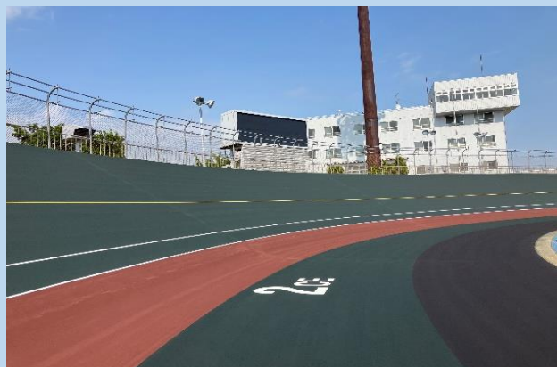
市営函館競輪場競走路表面処理等工事
