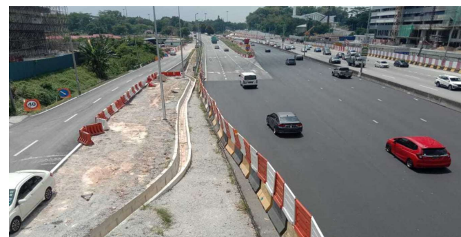
【マレーシア】シルク高速道路4車線拡幅工事
