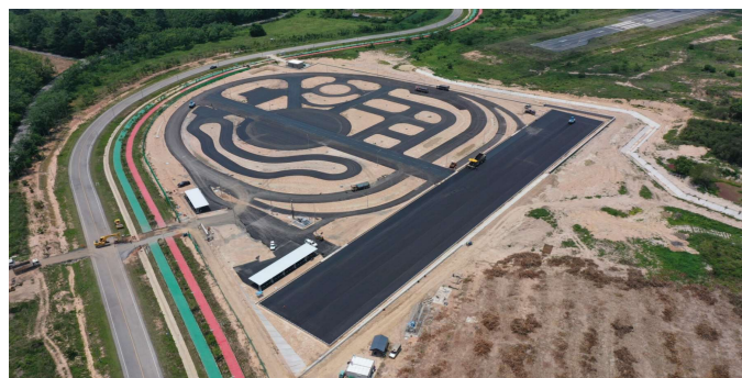
【タイ】CAVテストコース建設工事1期
