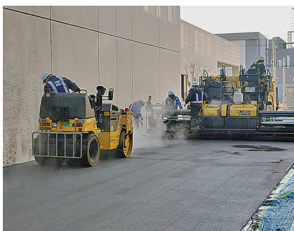
リサイクルした廃漁網の舗装材で施工
