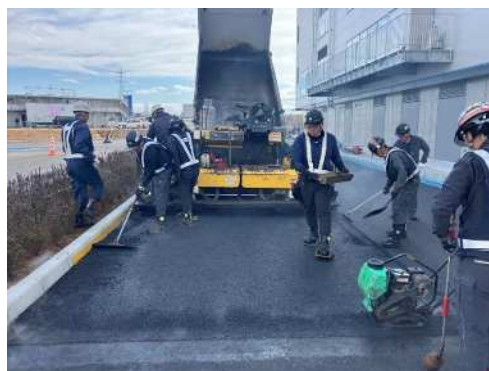
土浦テクノ BASE での施工の様子
