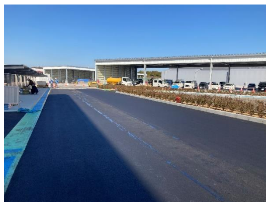
バイオ炭アスコン施工事例
