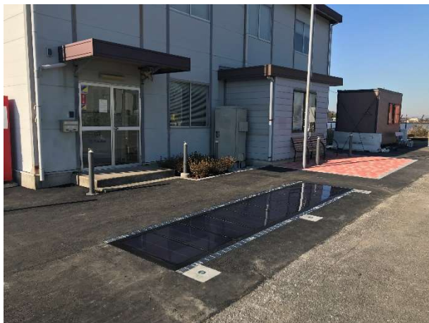
太陽光発電舗装（日中）
