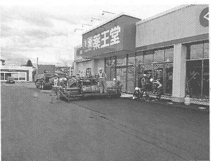
一般車用を初採用(岩手県、薬王堂一関山目店新築工事)
