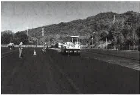
日本道路が施工した「トヨタ・オート・オークション広島会場」＝広島県東広島市
