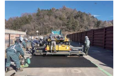
舗設温度100℃での試験施工状況
