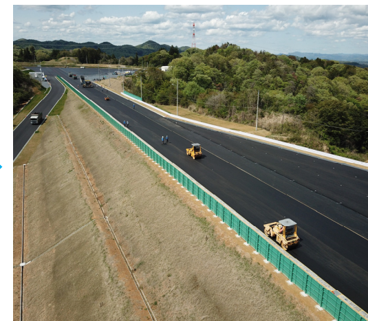
ADAS試験路はアスファルト舗装路面となります。アスファルトと砕石、砂を練り混ぜたアスファルト混合物で構築します。
