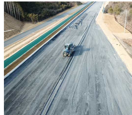
ADAS試験路の舗装構造の一つである路盤層工事です。岩石を砕いた砕石を敷きならして構築します。
