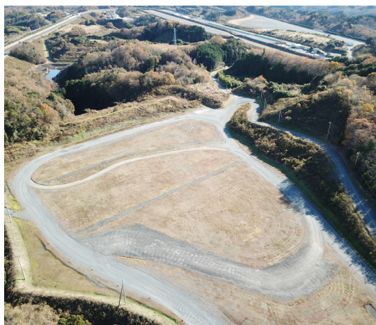
約70,000㎡の敷地に新たにADAS試験場を建設します。
