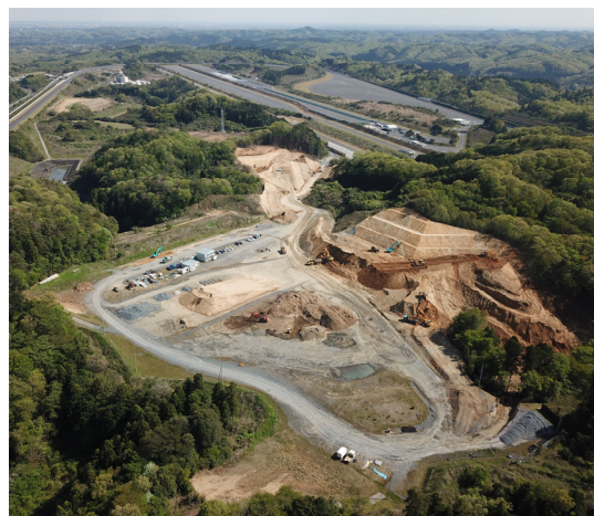
現況の山を切り崩し、切り崩した土を運んで盛土を行います。切土・盛土それぞれ約150,000㎡、大型ダンプで60,000台分となります。
