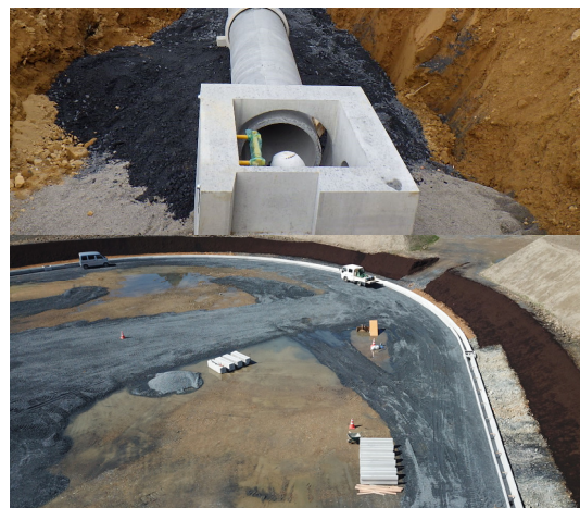
雨水排水を行うコンクリート構造物や地盤に浸入した湧き水などを排水する暗渠排水を施工します。
