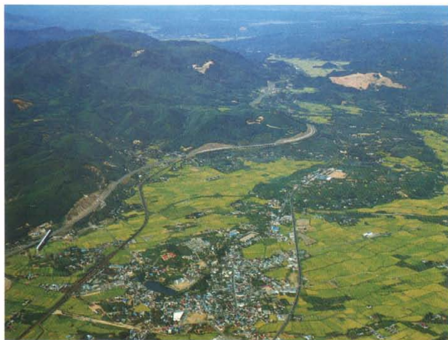
東北縦貫道国見舗装工事(昭和50年)
