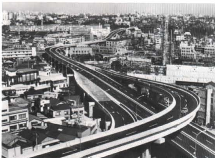
首都高速2号線舗装工事(昭和42年)
