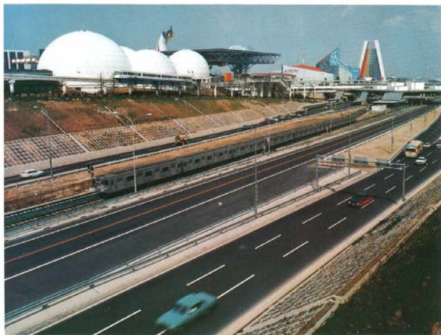
中国縦貫道吹田～豊中間舗装工事(昭和46年)
