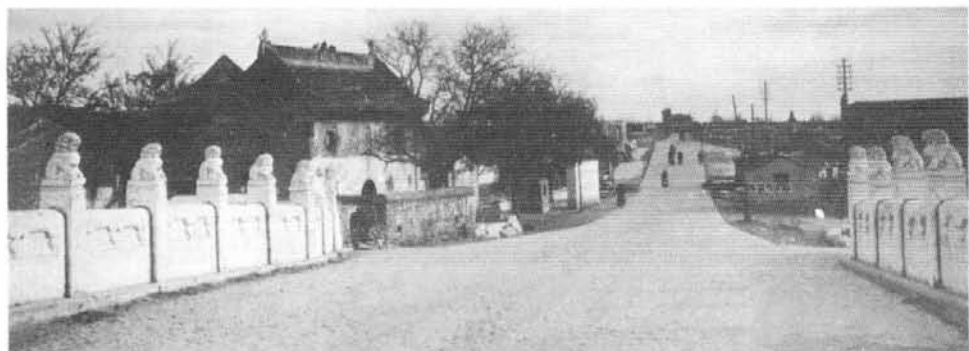
北京市蘆溝橋舗装 工事(昭和14年)
