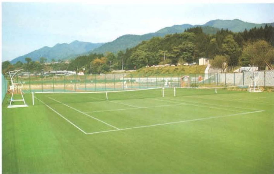
京都グリーンテニスクラブ工事(昭和50年)
