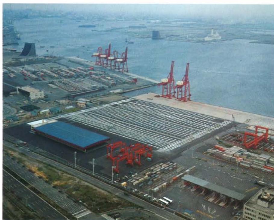
大井埠頭第3バースヤード工事(昭和49年)
