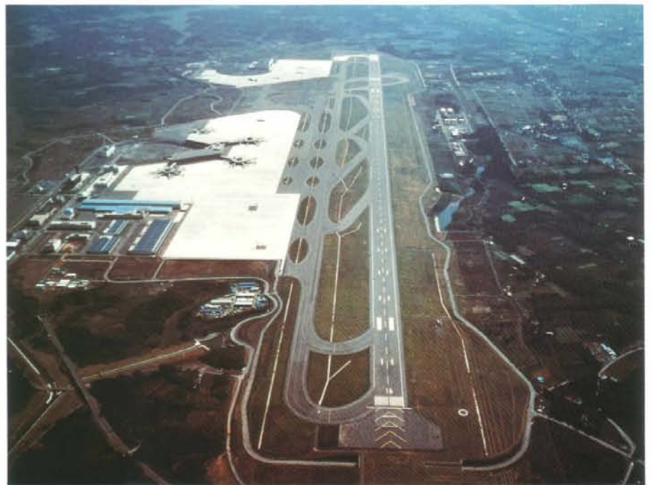
新東京国際空港エプロン舗装工事(昭和50年)
