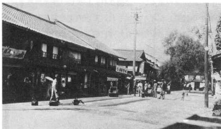
松山市内道路舗装工事（昭和11年）
