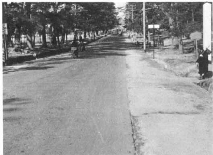
奈良―国道15号線舗装工事 (昭和26年)
