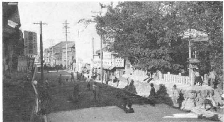
宇治山田市内路面補修工事(昭和12年)
