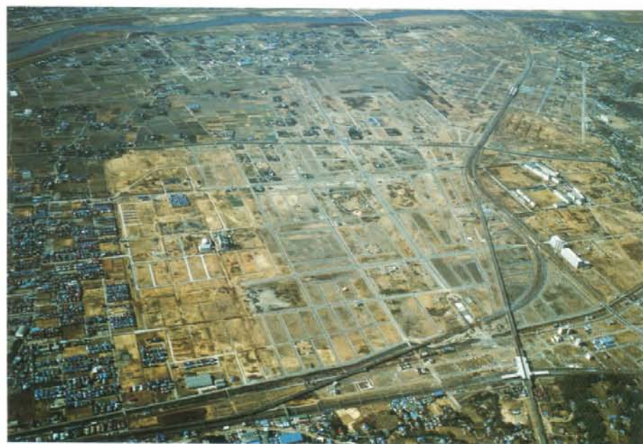
新松戸宅地造成工事(昭和49年)
