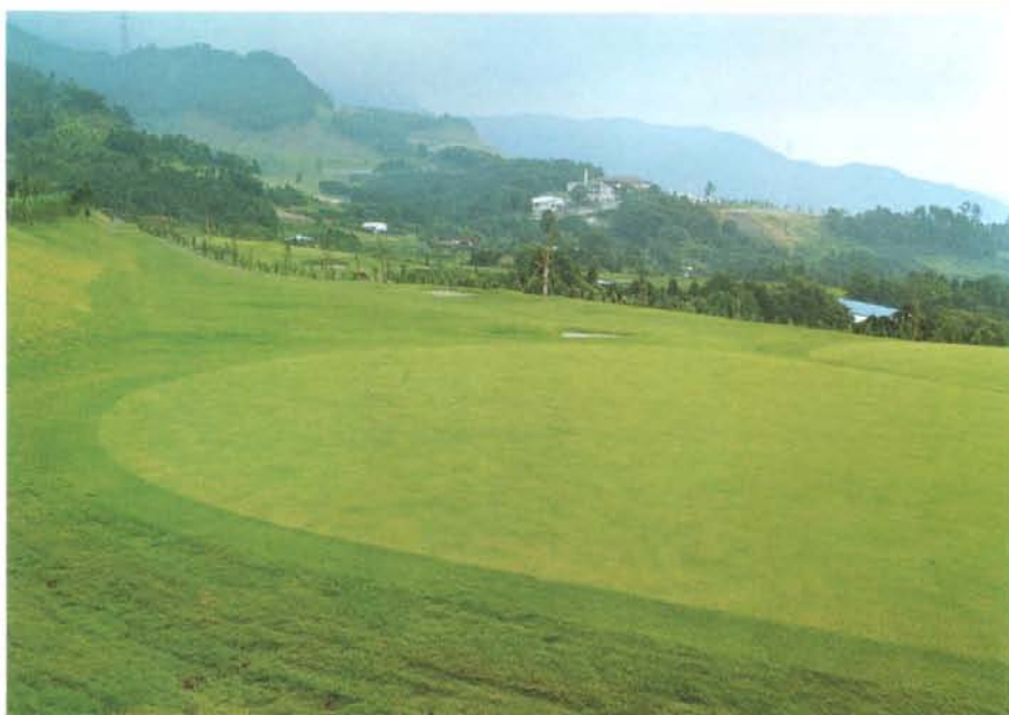
大秦野カントリークラブ造成工事(昭和52年)
