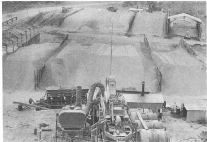
名神高速工事用のアスファルトプラントとストックヤード
