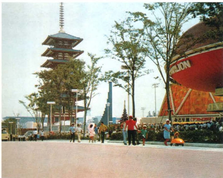
万国博覧会場内舗装工事(昭和44年)
