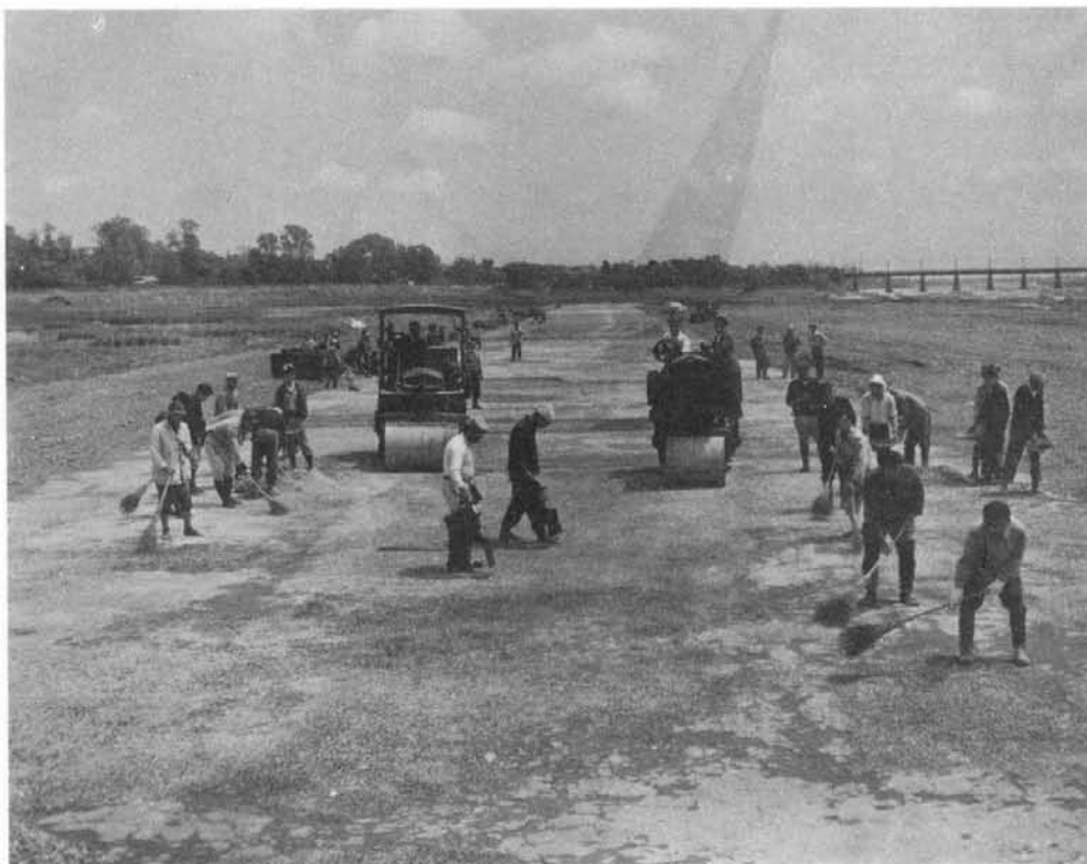
読売飛行場舗装工事（昭和26年）
