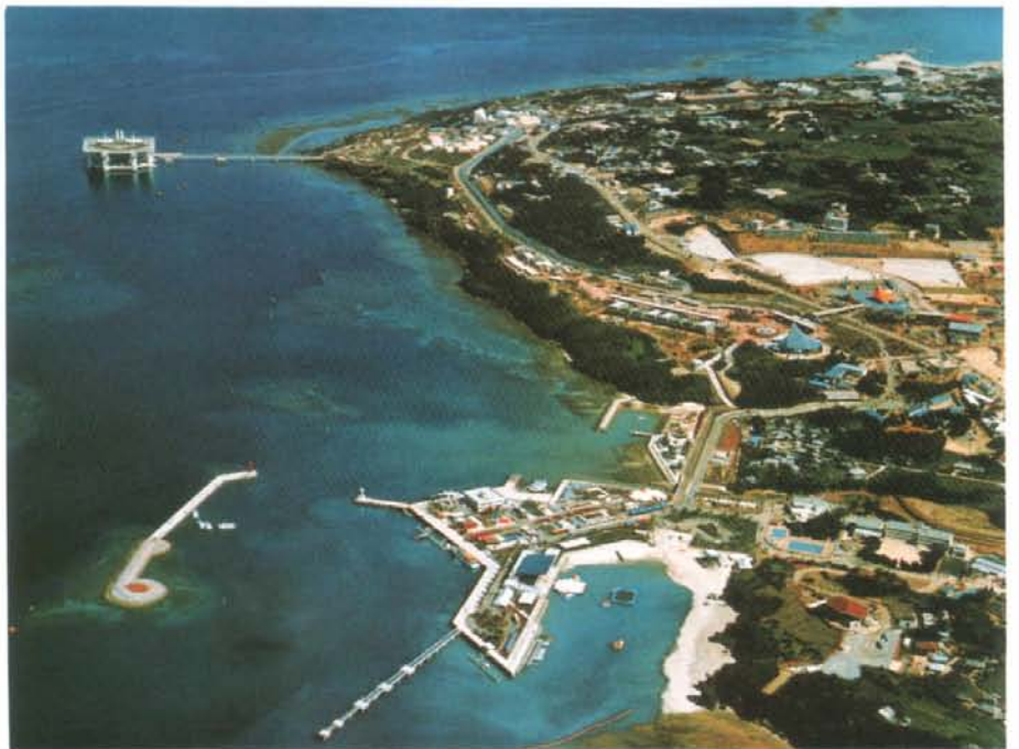
沖縄海洋博覧会場内舗装工事(昭和50年)
