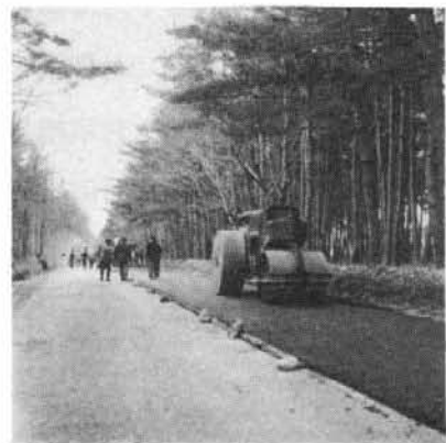
那須工事（昭和28年）
