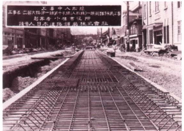
小樽市内街路舗装工事(昭和12年)
