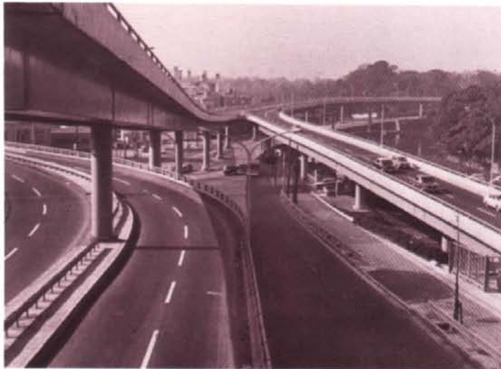
首都高速4号線舗装工事(昭和39年)
