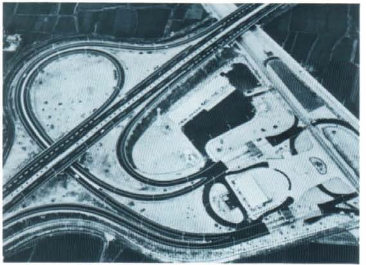
名神高速道路茨木～吹田間舗装工事(昭和37年)
