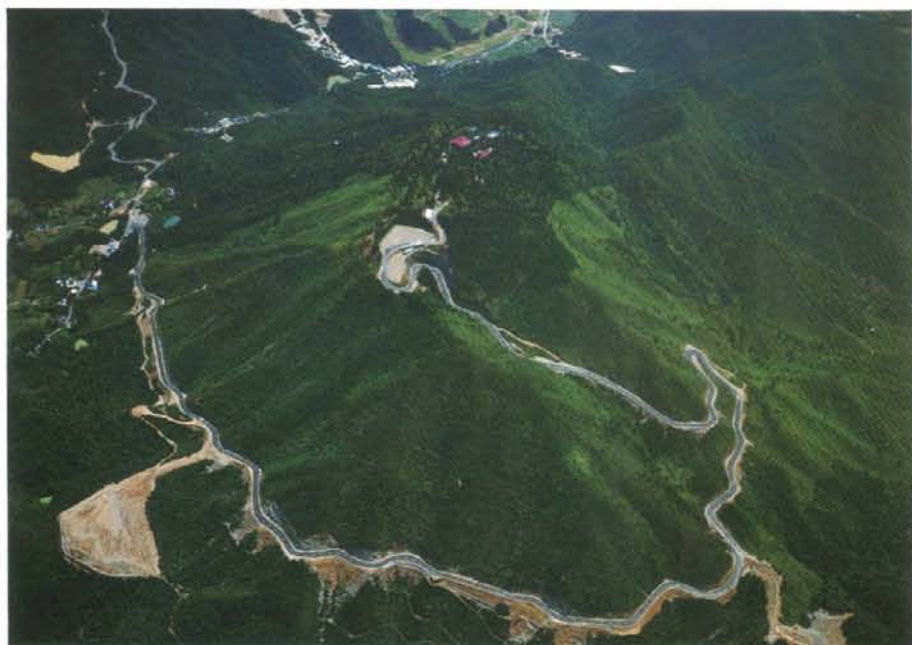
清水寺防災道路築造工事(昭和49年)
