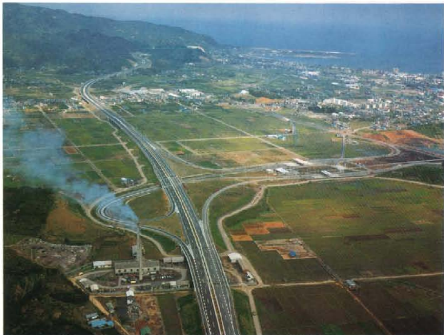
東名高速道路静岡～薩埵間舗装工事(昭和43年)
