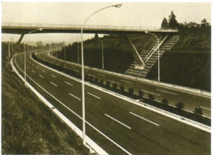
第三京浜道路横浜地区舗装工事(昭和40年)
