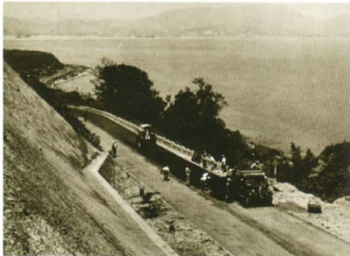
札幌国道舗装工事(昭和29年)
