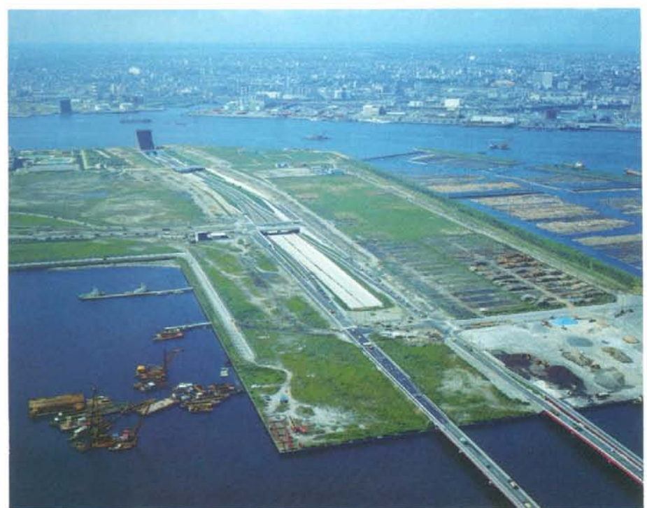
首都高速13号地開渠部舗装工事(昭和51年)
