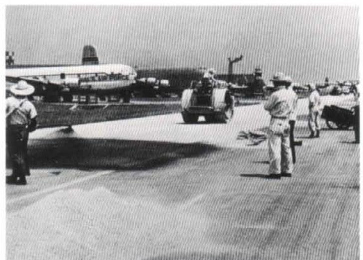
羽田国際空港滑走路舗装工事(昭和31年)
