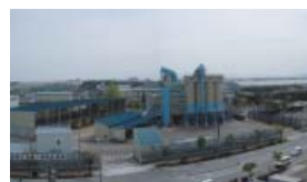
アスファルトプラント(仙台南アスコン)
