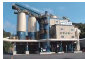
アスファルトプラント(福岡合材センター)
