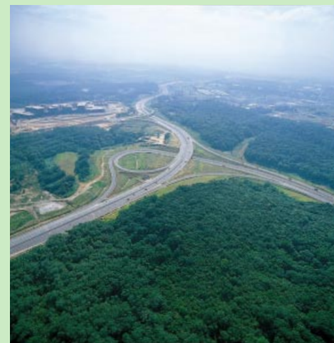
南クランバリー高速道路新設工事 1A工区（マレーシア）
