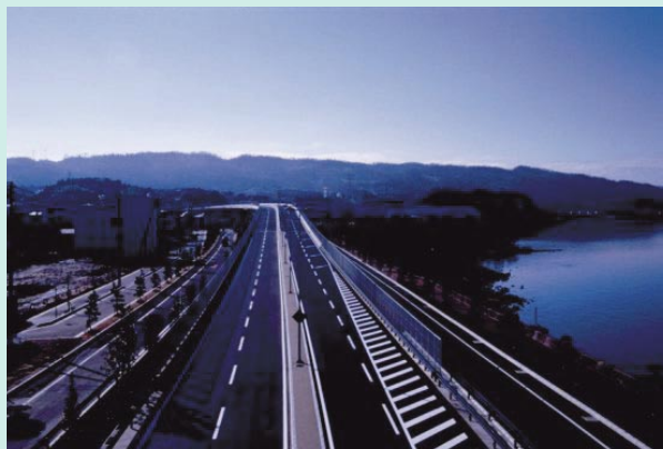
嫁島舗装第2工事（島根県）
