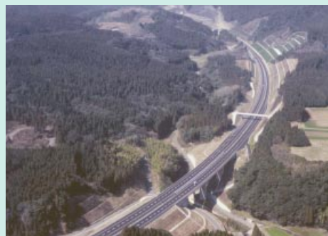
東九州自動車道財部舗装工事（鹿児島県）
