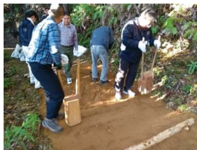
「タコ」による土の転圧
