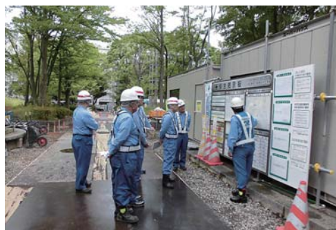
井口専務現場パトロール（東京支店）
