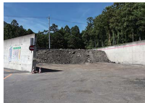
アスファルト塊の受け入れ
