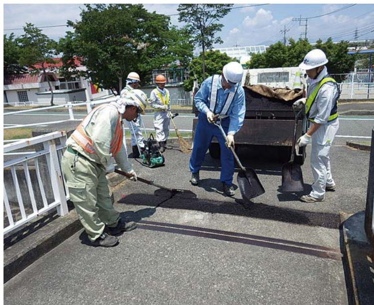
段差のすりつけ作業
