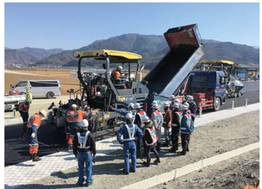
中部横断道での舗装施工現場の見学
