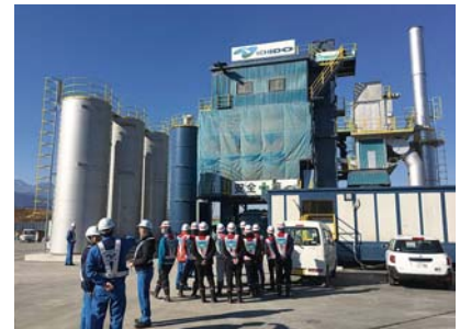
アスファルト合材工場の見学
