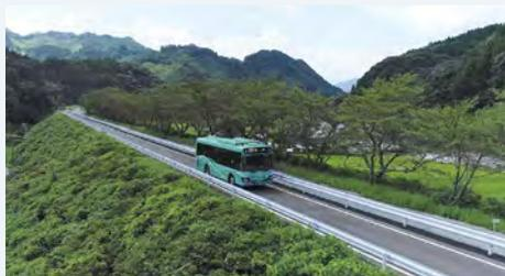
2017年の九州北部豪雨で被災したJR日田彦山線の一部区間に導入されたバス高速輸送システム「BRTひこばしライン(正式名称:日田彦山線BRT)」が、2023年8月に開業しました。彦山駅～宝珠山駅の約14kmのBRT専用道のうち、約6kmの区間にPETアスコンが採用されています。
