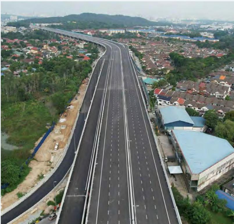
マレーシアでは近年の交通渋滞緩和のため、大手民活高速道路事業者のプロリントス社が、クアラルンプール首都圏にて高架高速道路建設を急ピッチで進めており、当高速道路もその一環として、ダマンサラ地区とシャーアラム地区を結ぶ全長20.1kmの高架高速道路として建設されました。当高速道路開通により、これまで90分かかっていた所要時間が30分に短縮され、渋滞緩和および交通量の分散にも大きく役立っています。日本道路マレーシア株式会社は、舗装工事のスペシャリストとして、同高速道路建設においてコンクリート床版上のアスファルト舗装と排水工事を担当しました。
